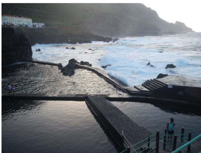
Piscine « naturelle » à vagues
